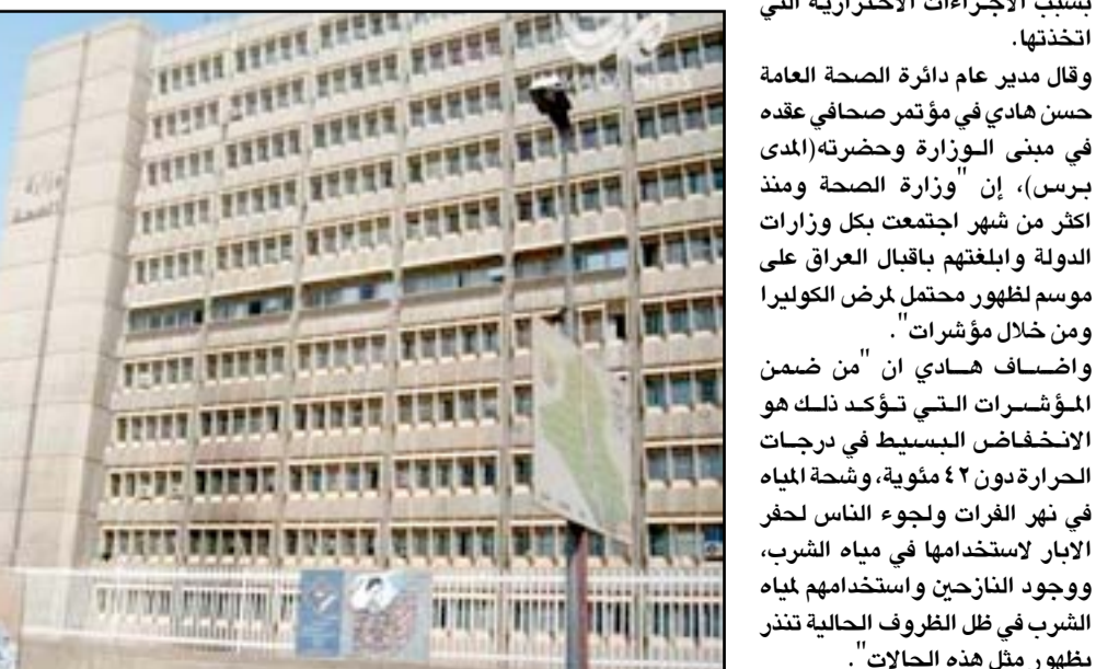
مبنى وزارة الصحة
